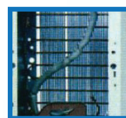
แผงคอนเดนเซอร์ เก็บมีเย็บควบคุม การทำงานด้วยมอเตอร์ ที่มีการป้องกันอากาศ เข้ามอเตอร์
